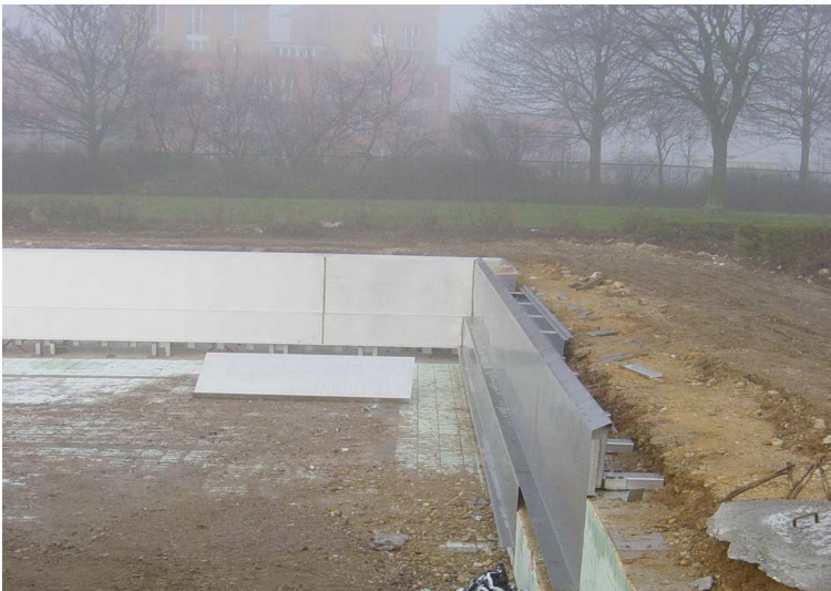
Les éléments en acier inoxydable sont montés directement sur le mur qui a été déblayé
