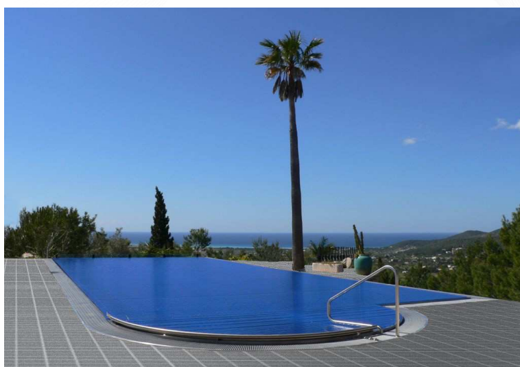
Piscine rénovée avec couverture à lamelles et paroi vitrée à l'avant Surface d'eau : 94,5 m 2 | Année de construction 2005
