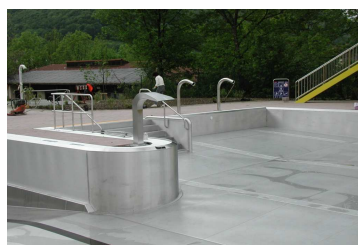
Après leur achèvement, les bassins en acier inoxydable nécessitent peu de maintenance et d'entretien
